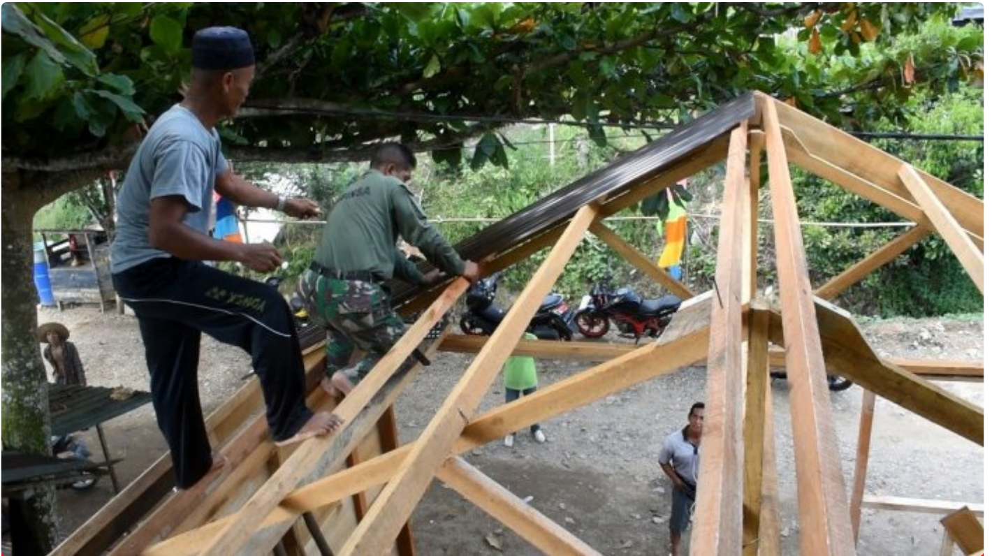
Sasaran Rehab Rumah Tidak Layak Huni Capai 30 Persen
