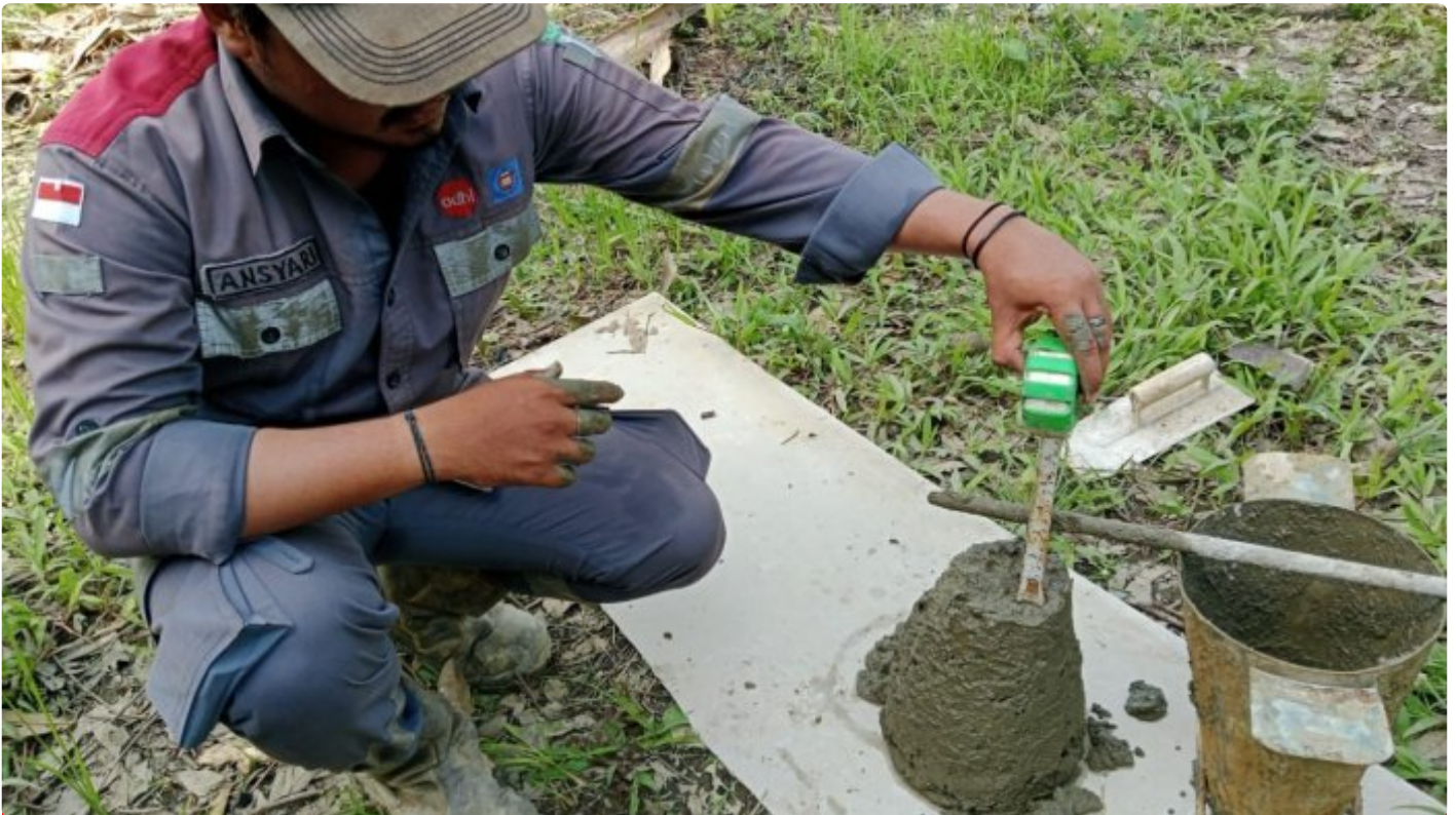
Uji Slump Beton Sasaran Jalan TMMMD ke-116 Kodim 1002/HST Oleh Dinas PU dan Konsultan
